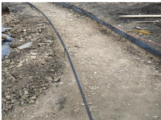
Obr. referenční obrázek: instalace ploché válcované oceli kotvené roxory do země
